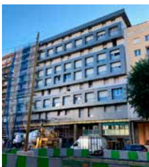
Chantier en cours de réalisation (juillet 2018)
